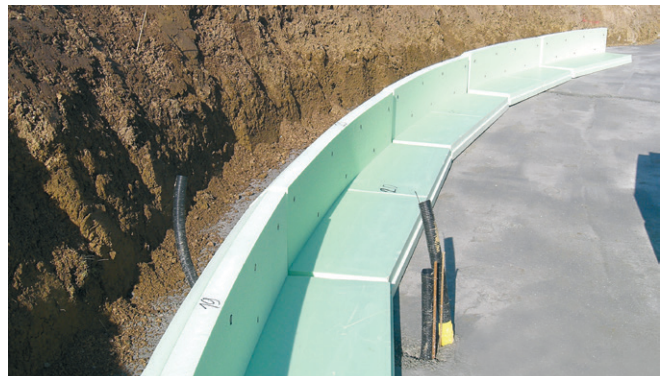
Abb. 35: Die werkseitig gefertigten, runden Randelemente werden nach den erforderlichen Radien ausgerichtet und verlegt. Somit lassen sich auch runde Bodenplattengrundrisse exakt und genau herstellen.
