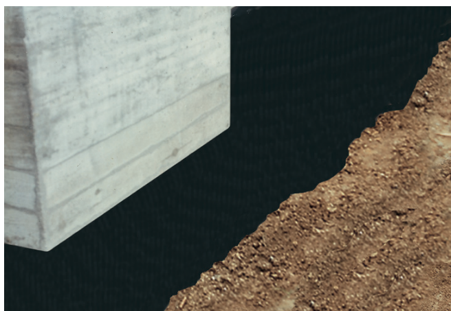
Abb. 15: Abdichtung der Kellerwand gegen drückendes Wasser.
