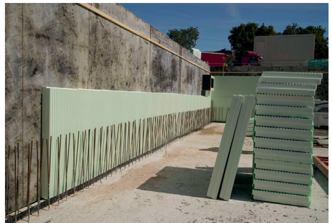
Abb. 30: Verlegung von Styrodur Hybrid an der Innenseite der Schalung
