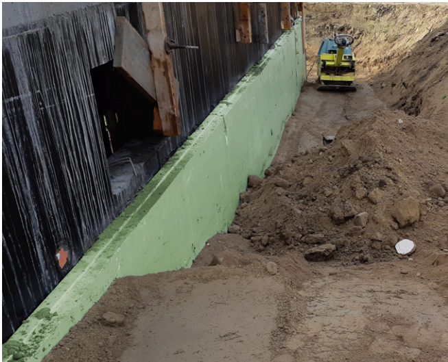
Abb. 28: Lagenweise Verfüllung der Baugrube
