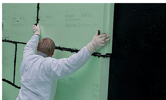
Abb. 17: Ansetzen der Styrodur-Platten und Verspachteln der Fugen gegen drückendes Wasser.
