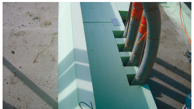
Abb. 42: Aussparungen oder Durchdringungen werden nach den baulichen Anforderungen und örtlichen Gegebenheiten ausgeschnitten. Spezial-PU-Schaum dichtet verbleibende Hohlräume ab.
