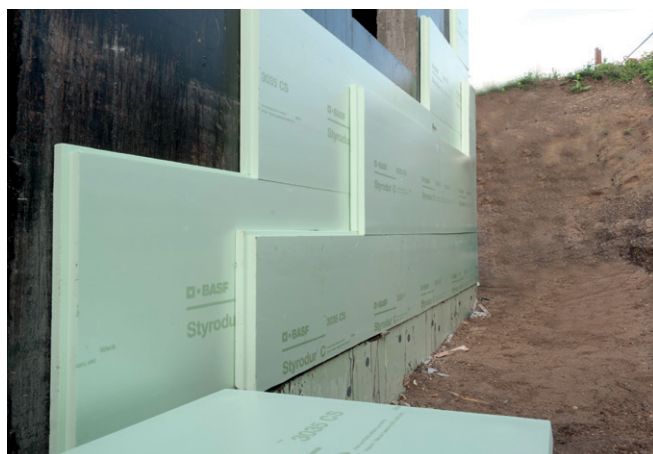
Abb. 3: Sicherung einer zweilagigen Perimeterdämmung aus Styrodur-Platten bis zum Verfüllen der Baugrube.
