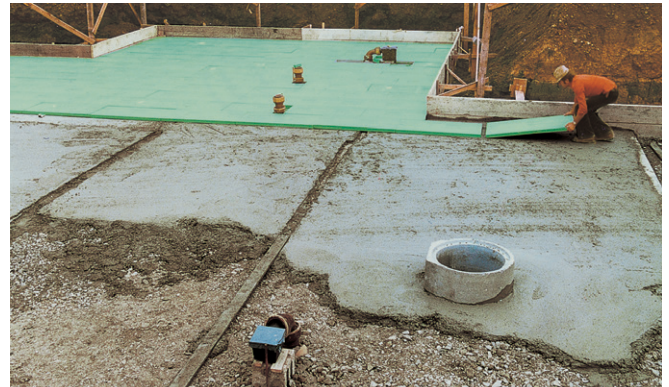
Abb. 6: Sauberkeitsschicht aus Magerbeton zur Verlegung der Bodendämmung.
