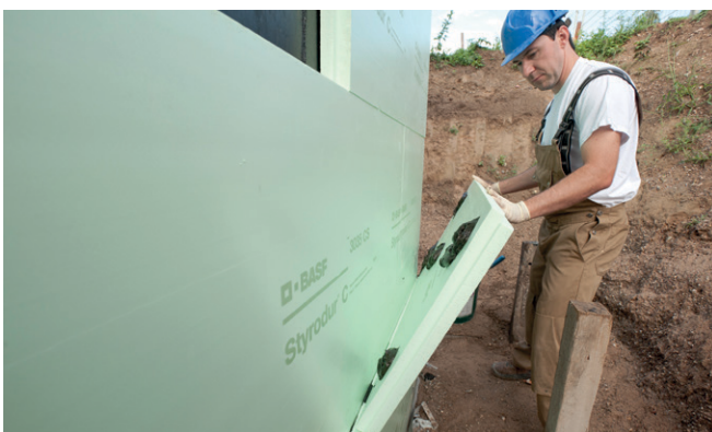
Abb. 5: Punktweise Verklebung der zweiten Lage Styrodur-Platten mit Stufenfalz und versetzten Fugen.
