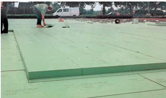
Abb. 8: Mehrlagige Verlegung von Styrodur-Platten unter Bodenplatte.
