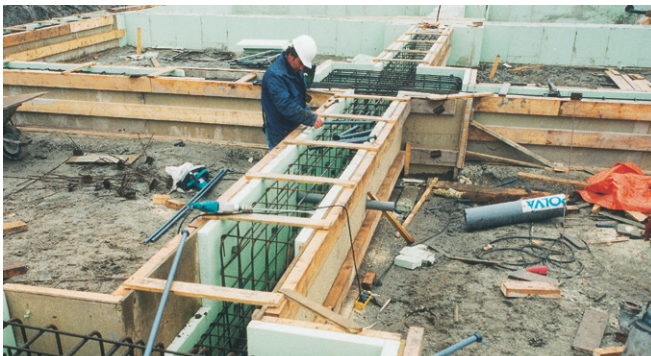
Abb. 25: Schalung mit Styrodur.
