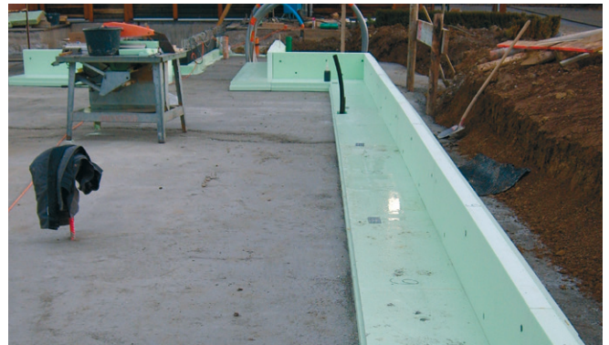
Abb. 34: Die Anordnung und Verlegung der geradlinigen Randelemente erfolgt nach einem je nach Objekt gefertigten Verlegeplan auf dem ebenen Unterbau.
